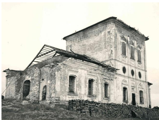
Рисунок 5 — Церковь Троицы в с. Зверинце. Вид с юго-запада. Фото 1968 г. Архив ГСООКН ЯО
