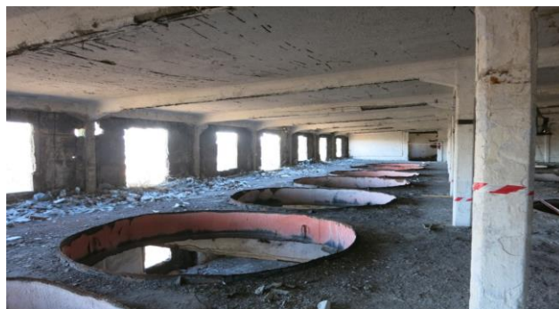
Рисунок 5 — Фотография перекрытия здания солодовни «Красная Бавария» (фото О. С. Крысановой)
