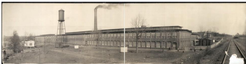
Рисунок 4 — Корпус фабрики: здание исторической хлопковой фабрики [ https://www.loc.gov/item/2007662771 ]
