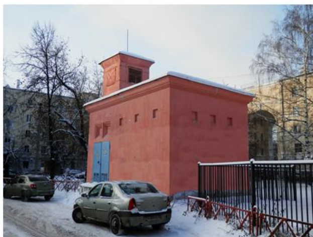
Рисунок 8 — Вид с северо-восточной стороны (фото О. В. Вяткина)
