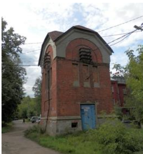
Рисунок 12 — Вид с северо-восточной стороны (фото О. В. Вяткина)
