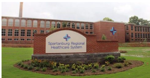
Рисунок 5 — Корпус фабрики: здание исторической хлопковой фабрики после реновации [ELBY BRUCE Former textile mill once again buzzes with activity]
