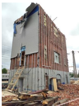
Рисунок 3 — Пост централизации после снятия сайдинга и разборки верхней части стен [фото О. А. Мазановой, 19.07.2023]
