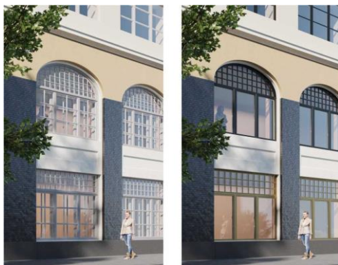
Рисунок 5 — Сравнение вида подлинных деревянных оконных рам и рам, установленных на объекте [материалы презентации концепции приспособления типографии. Автор — архитектурное бюро Kremnev atelier (г. Ярославль ООО «Кремнев ателье»)]
