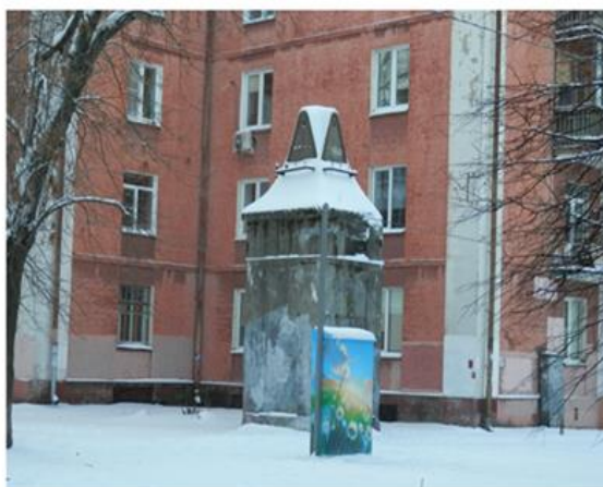
Рисунок 10 — Вид с северо-восточной стороны (фото О. В. Вяткина)
