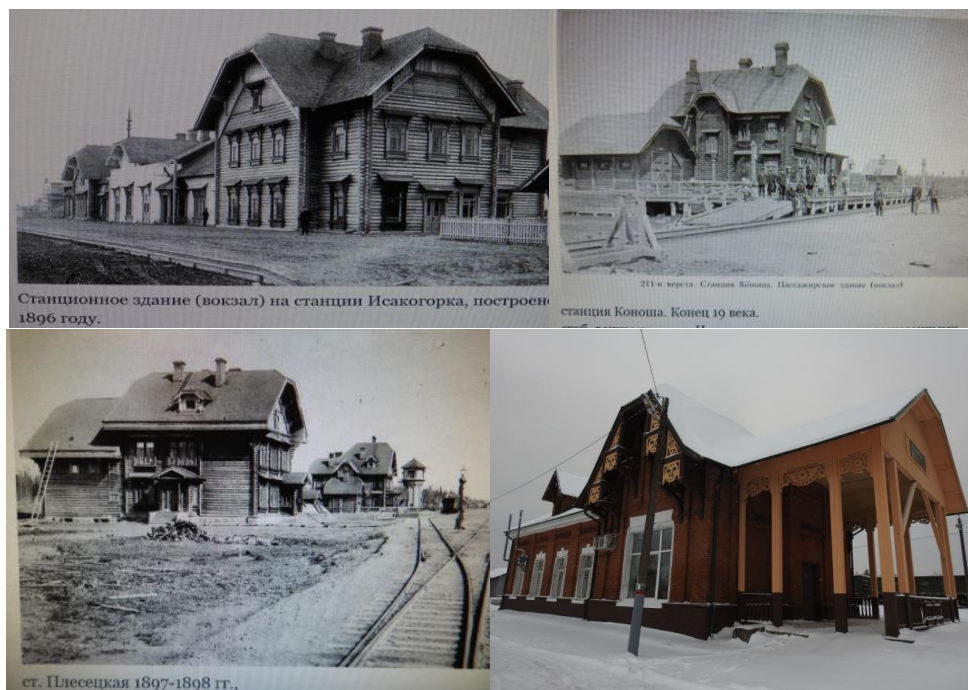
Рисунок 3 — Вокзалы ст. Исакогорка, Коноша, Плесецкая (фото из архива Северной железной дороги), ст. Лом (фото А. С. Емельянова)
