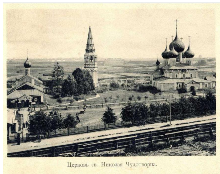
Рисунок 3 – Ансамбль Николо-Мельницкого прихода, г. Ярославль. Фото начала XX века [ https://sobory.ru/photo/374816 ]
