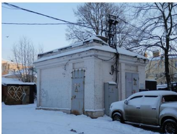
Рисунок 6 — Вид с северо-восточной стороны (фото О. В. Вяткина)
